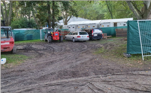
Bodenverdichtung, keine Vegetation, 1 Baum abgesägt
